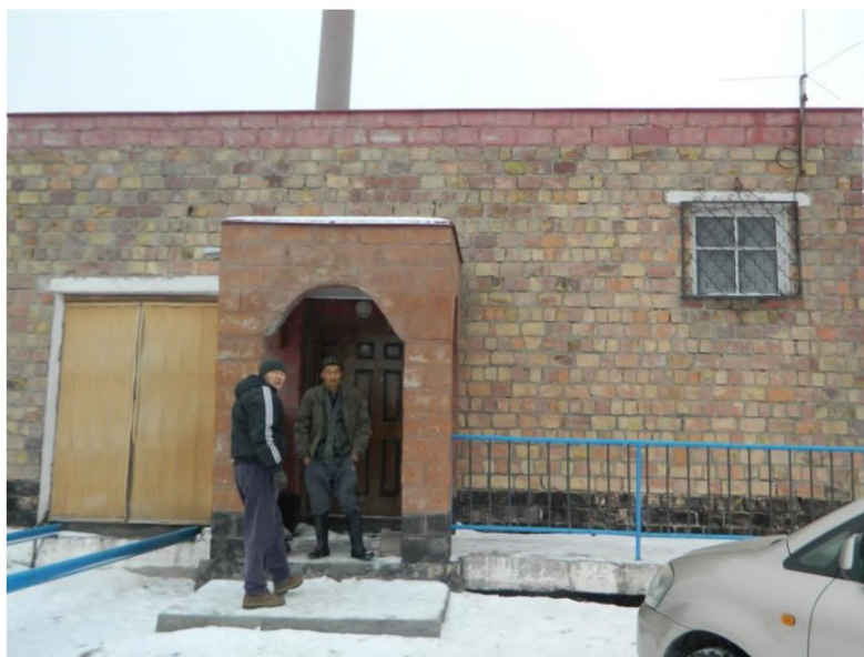
Рис. 8 – Пункт управления Ыссык-Атинского БДР
