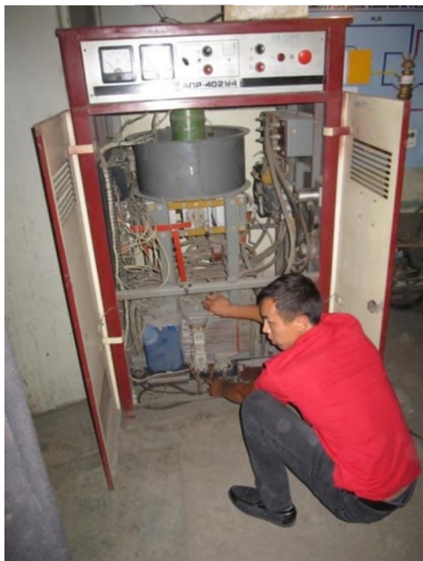
Восстановление и ремонт силовых кабелей установки
