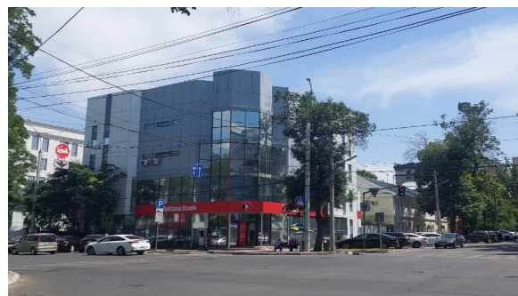
Рисунок 10 – Бишкекский центральный офис «Оптима банка», ул. Киевская, 104
