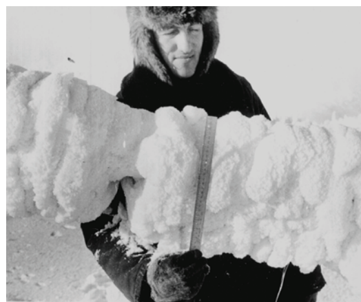
Рисунок 2 – Отложение на опоре горной ВЛ плотной изморози массой 20 кг/м в Кыргызстане (слева) и на опытном пролете массой 35 кг/м на Урале (справа)
