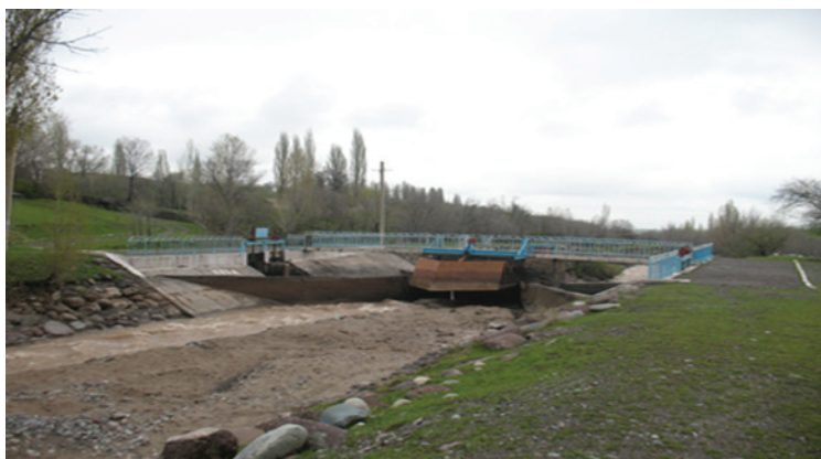
Рисунок 1 – Головное водозаборное сооружение на р. Ак-Суу
