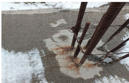
Рисунок 7 – Открытый участок колонны в осях «4/А»
