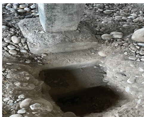
Рисунок 5 – Выполненный шурф в осях «2/В»
