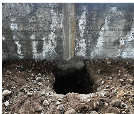
Рисунок 4 – Выполненный шурф в осях «1/В»
