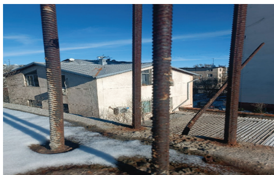
Рисунок 6 – Открытый участок колонны в осях «4/Б»
