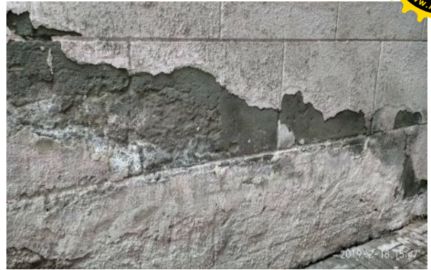
Рис.3. Биоповреждения, солевая коррозия штукатурки фасада
