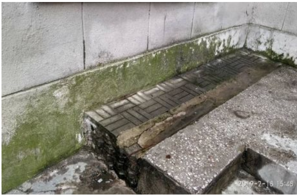
Рис.3. Биоповреждения, солевая коррозия штукатурки фасада
