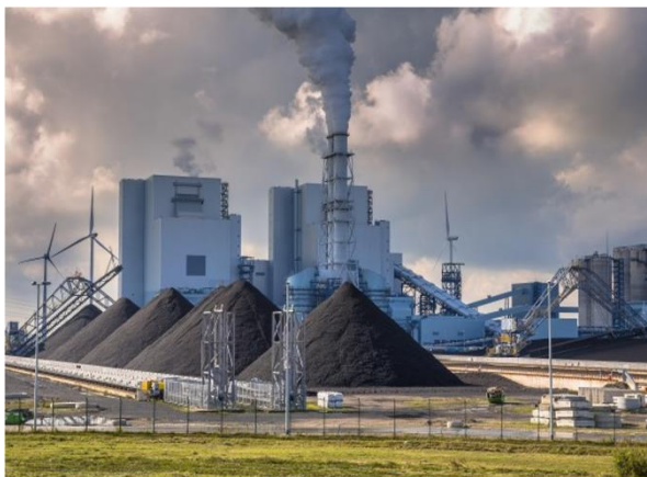
2-сүрөт. Көмүр электир станциясы
