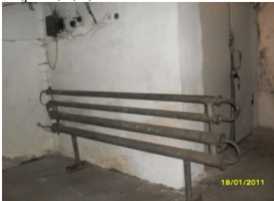
Рис.1. Охладитель «труба в трубе»
