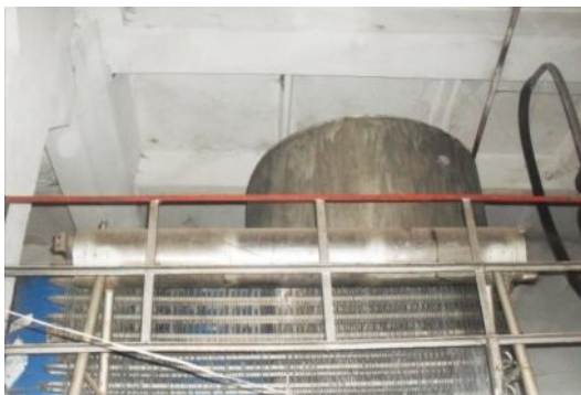
Рис. 2. Охладитель – рекуперативный многоходовой теплообменник
