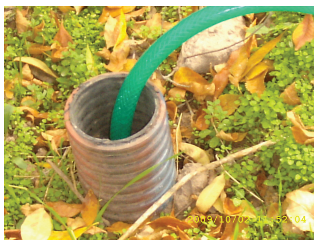
Рисунок 4 – Колодец гидранта с поливочным шлангом
