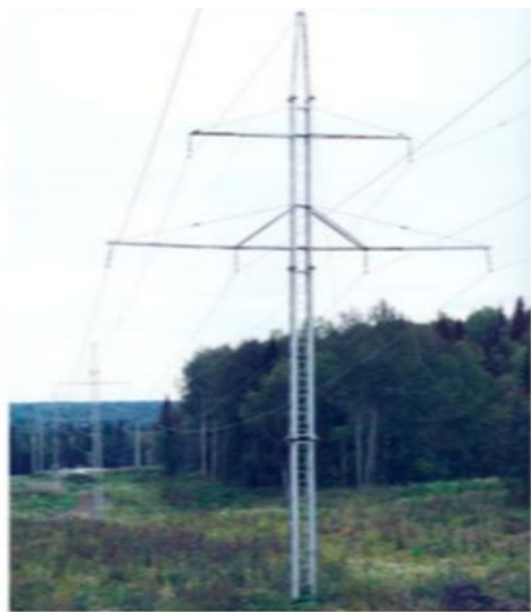
Рис. 46. Промежуточные узкобазовые опоры для воздушных линий напряжением 35 и 110 кВ
