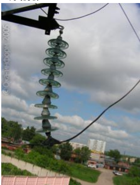
Рис. 14. Гирлянда изоляторов Рис. 15. Полимерный изолятор ЛК70/35
