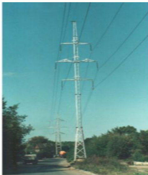
Рис. 46. Промежуточные узкобазовые опоры для воздушных линий напряжением 35 и 110 кВ
