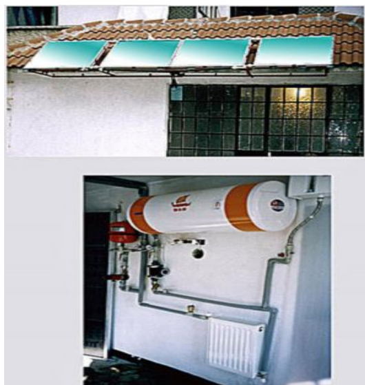
Рис. 5. Схема расположения солнечной водонагревательной установки
