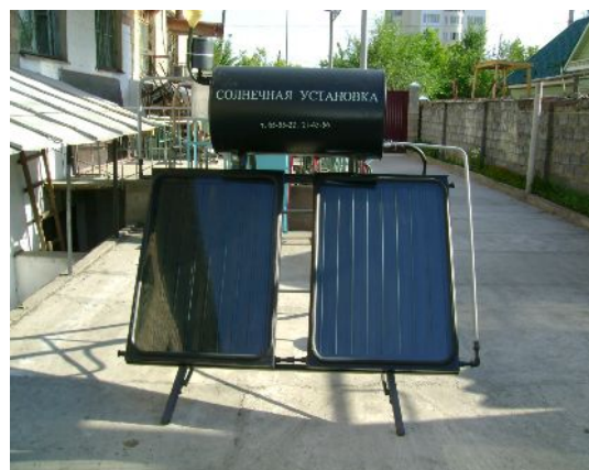
Рис. 4. Солнечный коллектор и установка для нужд горячего водоснабжения
