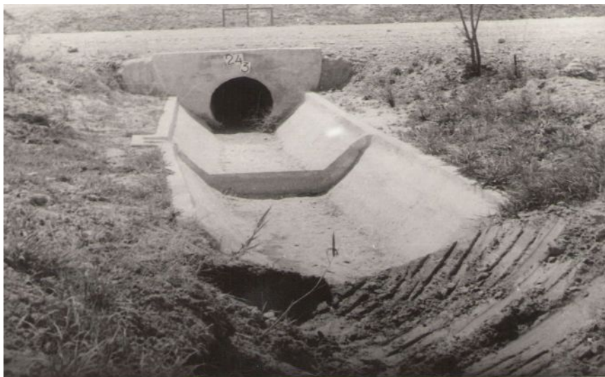
Рис. 3.15. Гидропост на Р-24-3 Оросительная система ЗБЧК.
