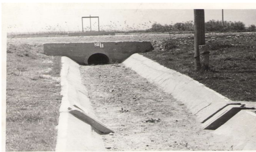
Рис. 3.14. Гидропост на P-21-1 Оросительная система ЗБЧК.
