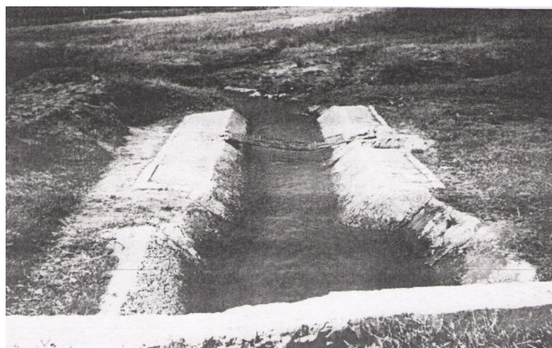
Рис. 3.9. Гидропост №7 на отводе канала Сапарбаева-2 ( вид с верхнего бьефа).
