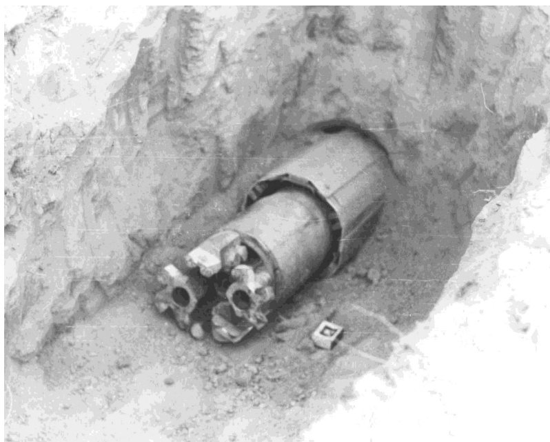
Рис. 19. Главный привод подземного проходческого робота
