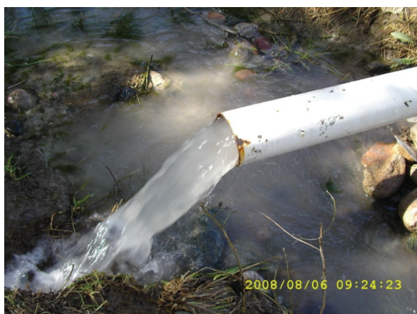
Рис. 6. Выход поднятой воды гидротараном на высоту 1,85 м в участковый распределитель парковой зоны факультета АДис КРСУ
