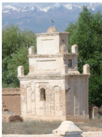
Рис. 1. Центрический мавзолей башенного подтипа, с. Тору-Айгыр
