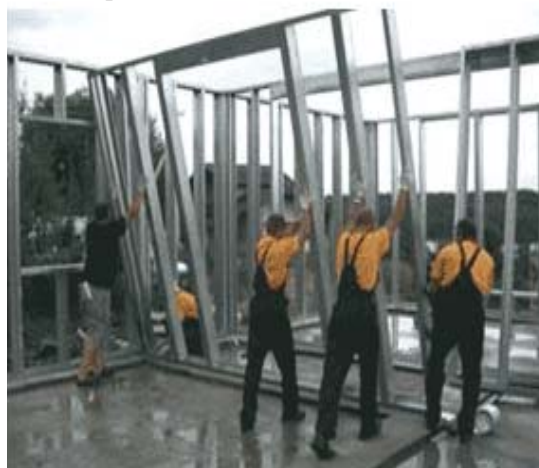
Рис. 6. Монтаж каркаса жилого дома из ЛСТК.
