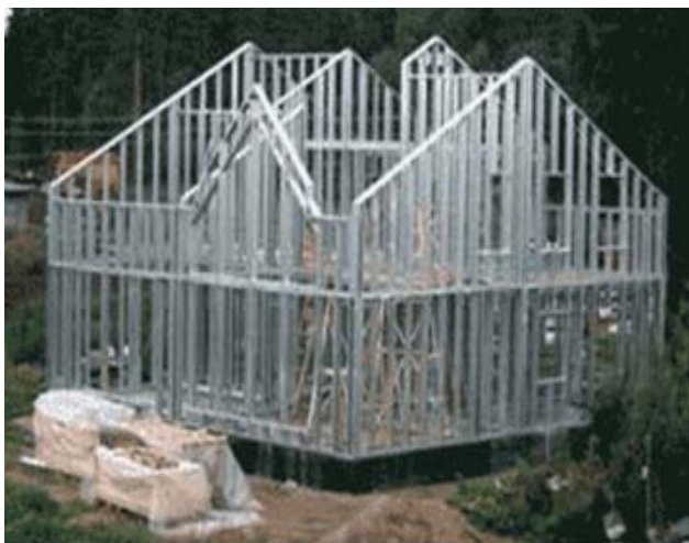
Рис. 4. Каркас одноэтажного жилого дома.
