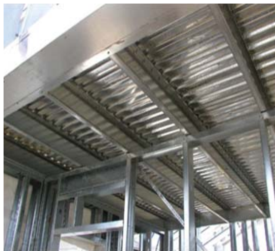
Рис. 5. Междуэтажное перекрытие из ЛСТК.
