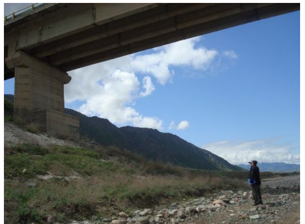
Фото 20. Исследование моста снизу биноклем (увеличение 12*)
