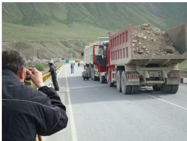
Фото 11. Нивелирование поверхности моста на втором пролете (3-е загрузеие)
