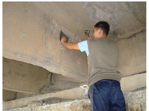
Фото 4. Определение класса бетона на балке первого пролета эталонным молотком Кашкарова
