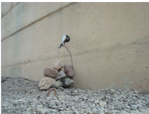
Фото 5. Установка прогибомера Максимова у второй опоры
