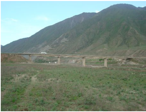
Фото 1. Общий вид моста
