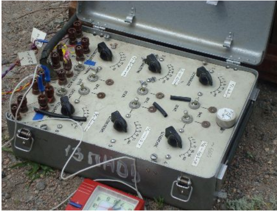
Фото 15. Шунтовая коробка ШК-2
