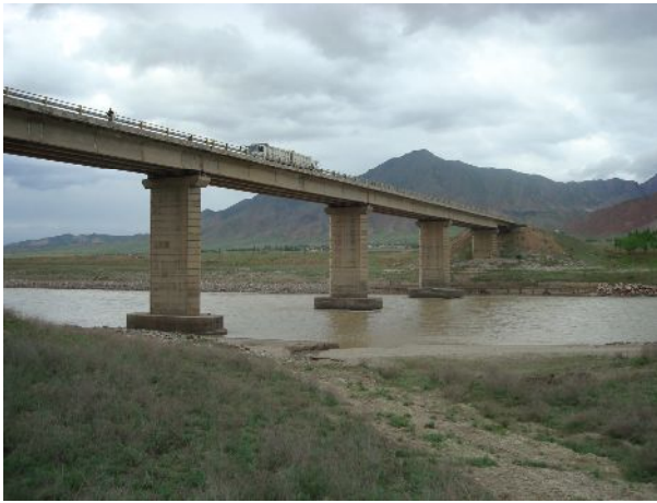
Фото 21. Вид 4-го пролета при втором загрузении (2 грузенных автотранспорта)
