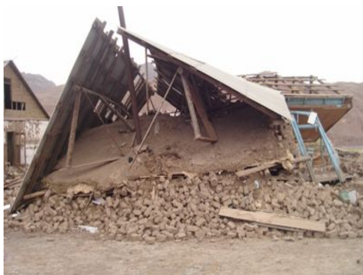
Рис.1. Полное разрушение кирпичных зданий. Алайское землетрясение, Нура, 2008 г.
