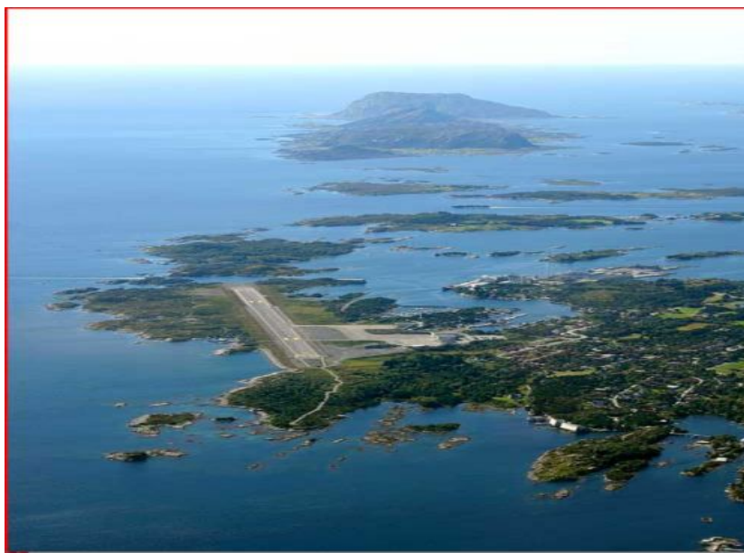
Рис. 1. Аэродром на реконструированном острове
