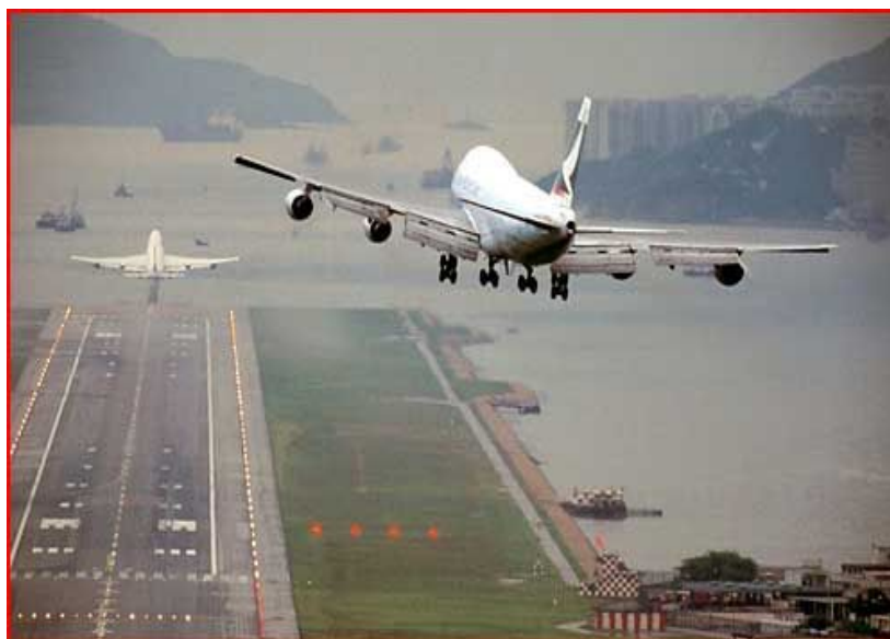
Рис. 2. Аэродром на искусственной насыпи
