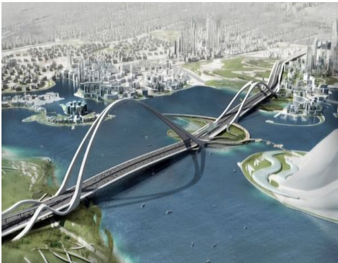
Рис. 1.22. Вантовый арочный мост, Дубай
