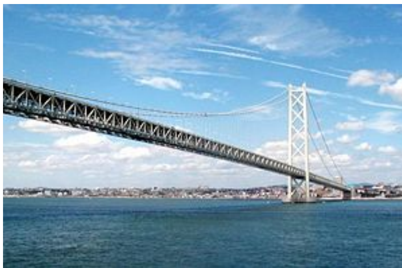
Рис. 1.24. Мост Акаси-Кайкё, Япония
