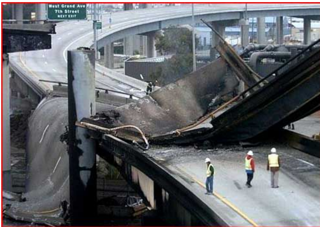
Рис. 1.17. Обрушение эстакады в Японии
