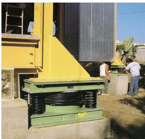
Рис. 1.14. Пружинный демпфер под трехэтажным домом
