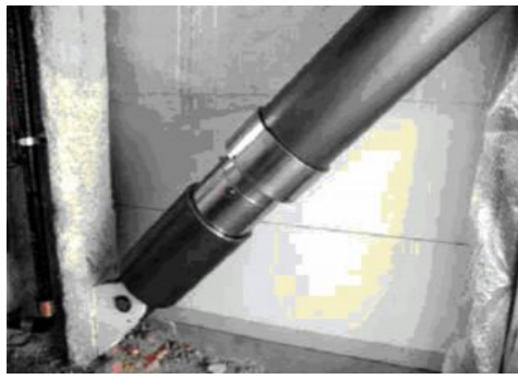
Рис. 1.8. Жидкостный вязкоупругий демпфер в здании
