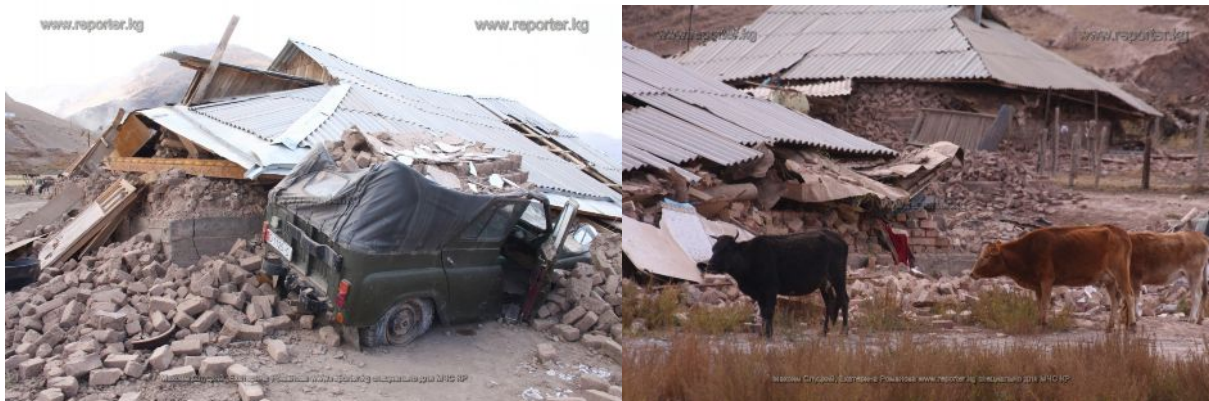
Рис.1. Землетрясение в с. Нура
