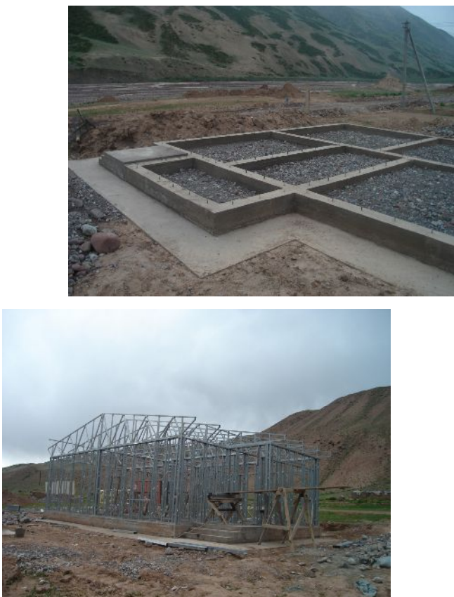
Рис. 3. Этапы строительства быстровозводимых жилых домов в с. Нура
