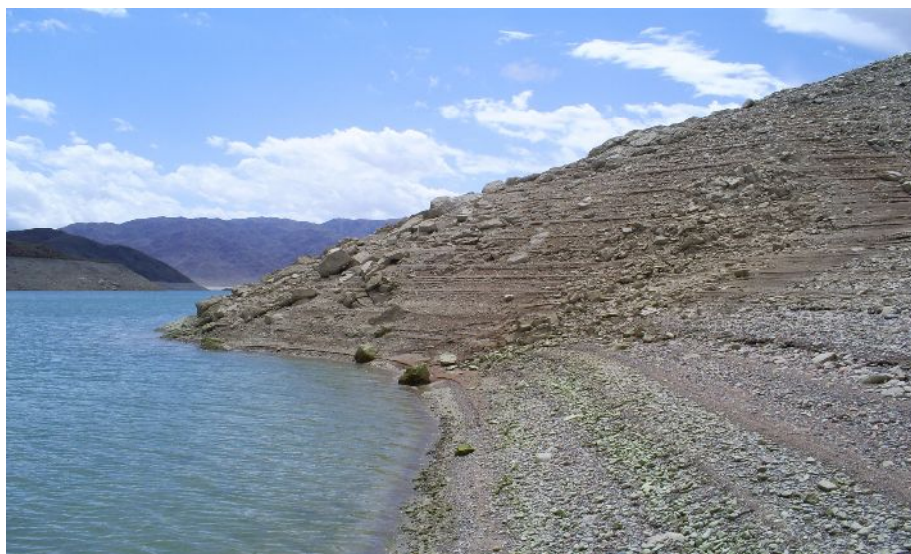
Рис. 3. Правый борт водохранилища
