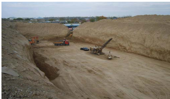
Котлован под 16-этажное здание в г. Шымкент (Южный Казахстан).
