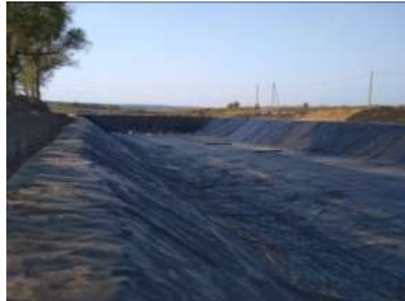
Рисунок – 5.7. Применение геомембран в гидротехнических сооружений
