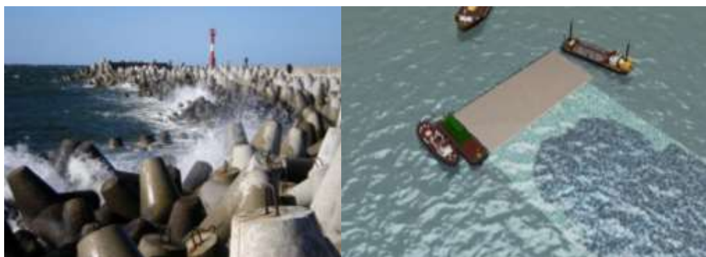
Рисунок – 5.3. Берегоукрепление с использованием бетонных тетраподов
