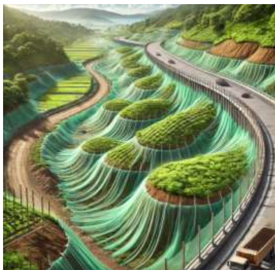
Рисунок 7.4.. Применения биотехнических методов укрепления откосов при строительстве магистрали в Индии
