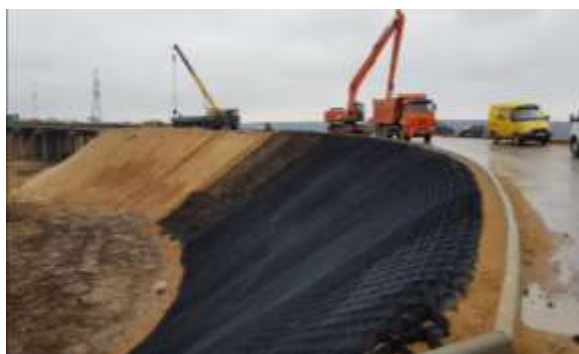
Рисунок – 5.5. Применение геотекстиля
