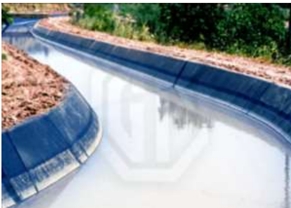
Рисунок – 5.7. Применение геомембран в гидротехнических сооружений
