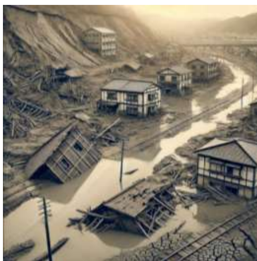
Рисунок – 1.1. Последствия землетрясения в Ниигате (Япония, 1964 год), включая разжижение грунта и повреждение инфраструктуры
