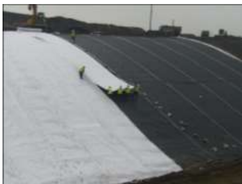
Рисунок – 5.5. Применение геотекстиля
