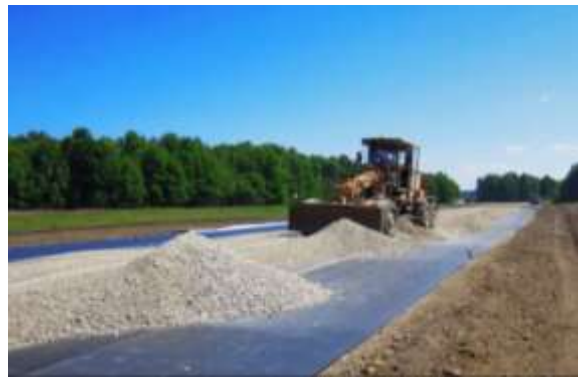
Рисунок – 5.6. Применение геосинтетических материалов
