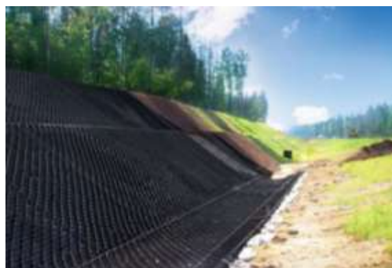
Рисунок – 5.2.Использованные объемные георешетки
