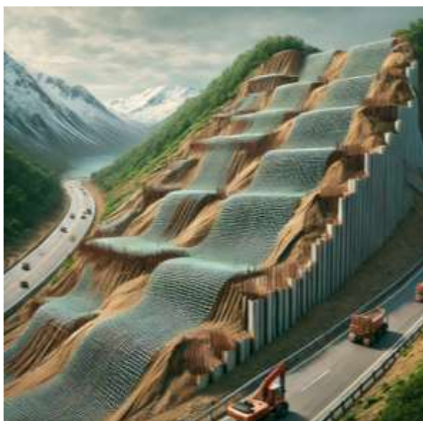
Рисунок 7.3. Укрепления откосов в Чили с использованием геосеток после землетрясения 2018 года.
