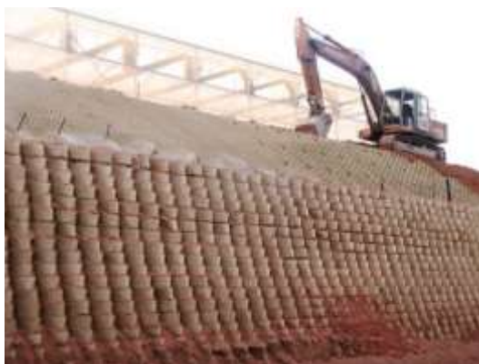
Рисунок – 5.2.Использованные объемные георешетки
