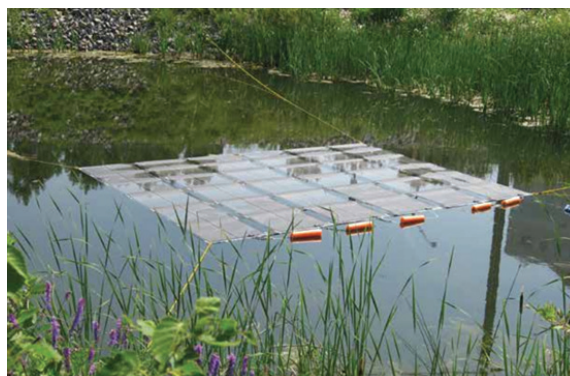
Рисунок 5 – Конструкция гибкой погружной ПСЭС
