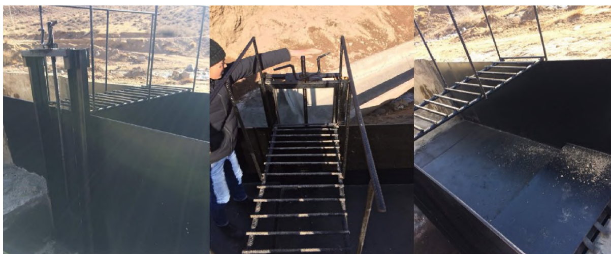
Рис. 5. Реализация водовыпуска-стабилизатора расхода воды из каналов с бурным режимом течения.
