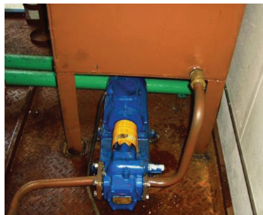
Рисунок 6 – Резервный масляный бак с маслоподкачивающим насосом
