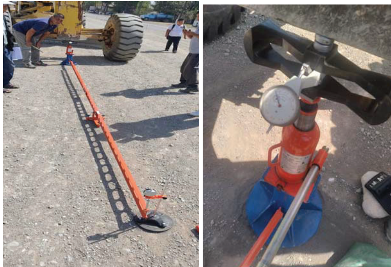
Рисунок 4 – Штамповые испытания конструкции дорожной одежды
