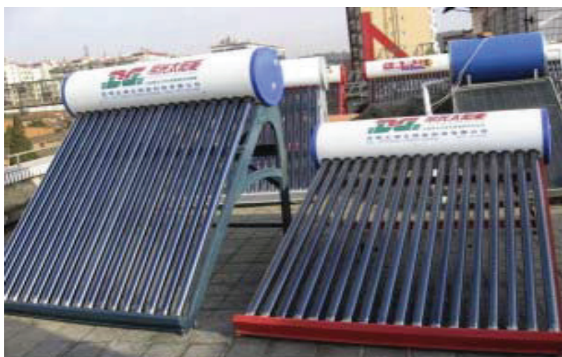
Рисунок 1 – Одноконтурные солнечные водонагреватели
