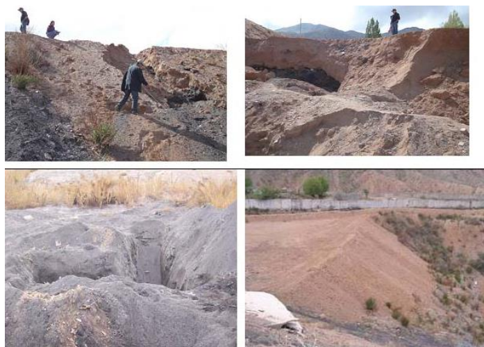
Рис. 2. Современное состояние хвостохранилищ
