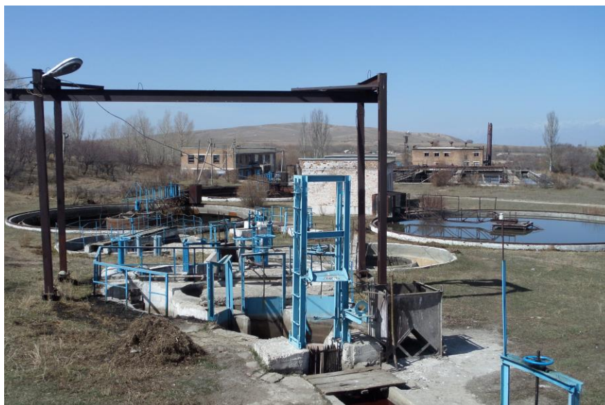
Рис.3.21. Очистительные сооружения сточных вод г. Каракол
