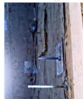
Крепление подконструкции с изнутри стены дома
