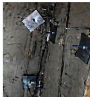
Крепление подконструкции с изнутри стены дома
