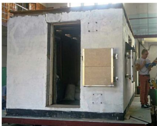
Монтаж подконструкции в смежных стенах дома
