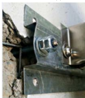
Крепление подконструкции снаружи стены дома
