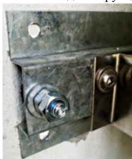
Крепление подконструкции снаружи стены дома
