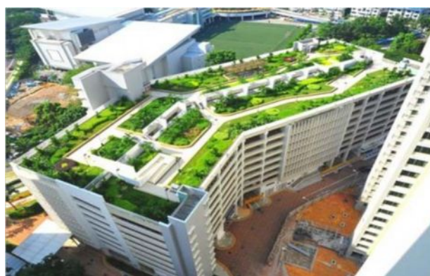
3- сүрөт, Сингапур Punggol, Эко-системасы бар "Жашыл белги" (Green Mark) белгидеги көп кабаттуу турак үй.
