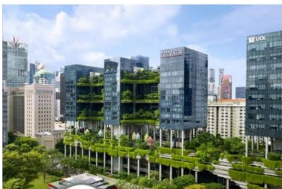
2- сүрөт, Сингапур Parkroyal. Эко-система "Жашыл белги" (Green Mark), аба (шамал) агымын жакшыртууну ишке ашыруу.
