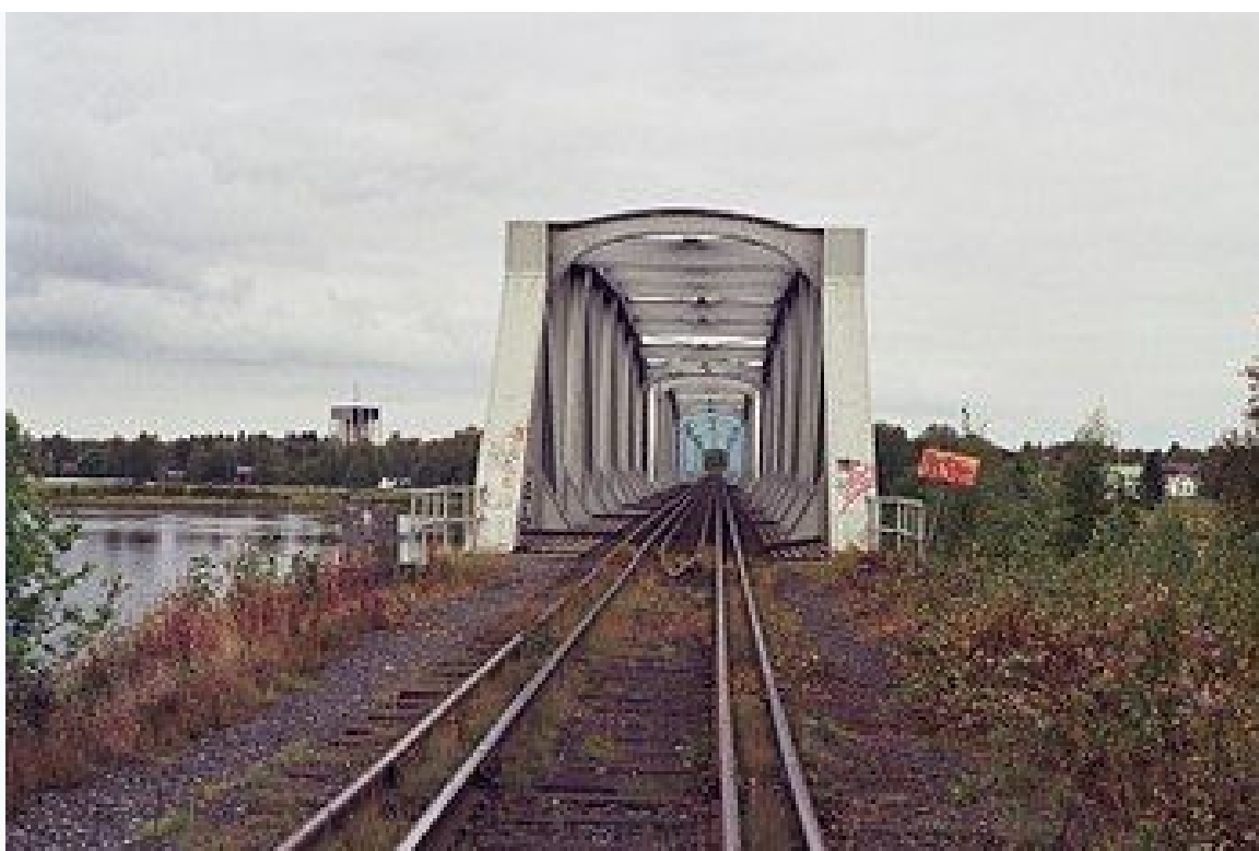
Рисунок 1.12 – Расположение рельсов на границе Швеции и Финляндии, слева направо: первый и третий рельсы: колея 1524 мм (Финляндия), второй и четвертый рельсы, колея 1435 мм (Швеция)
