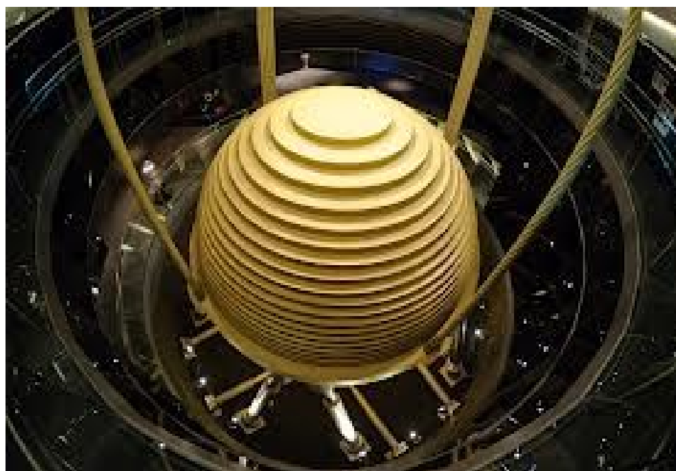
Рисунок 3.1 - Инерционный демпфер высотного здания
