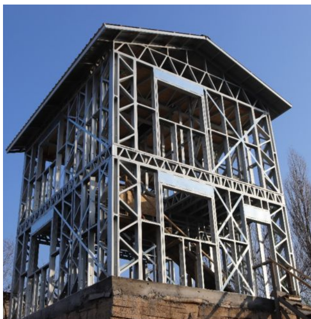
Рисунок 5.42 Здание из легких стальных конструкций в разном состоянии обшивки
