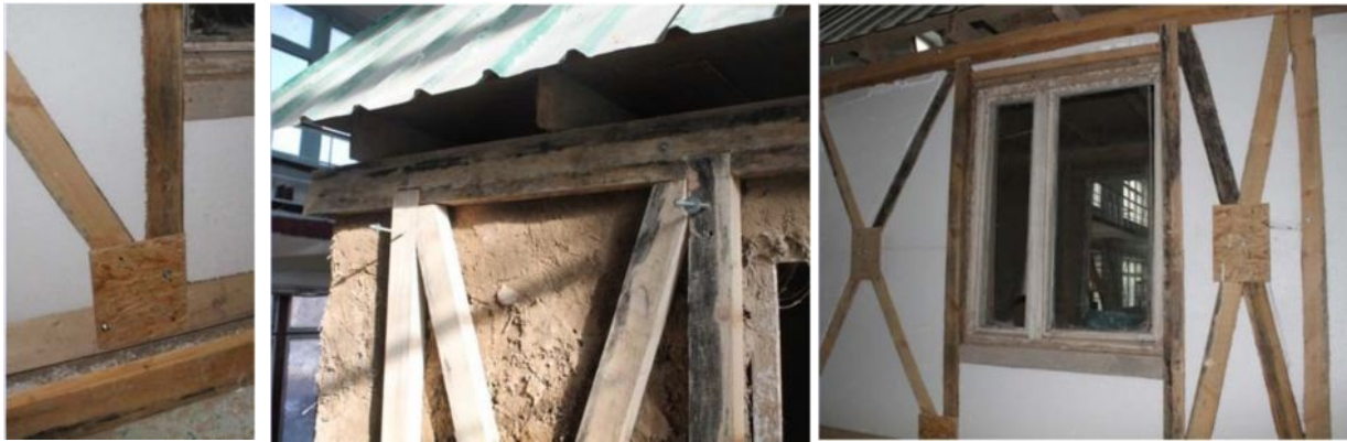
4-Сүрөт. Жыгач конструкцияларынын биригүү түйүндөрүнүн көрүнүштөрү
