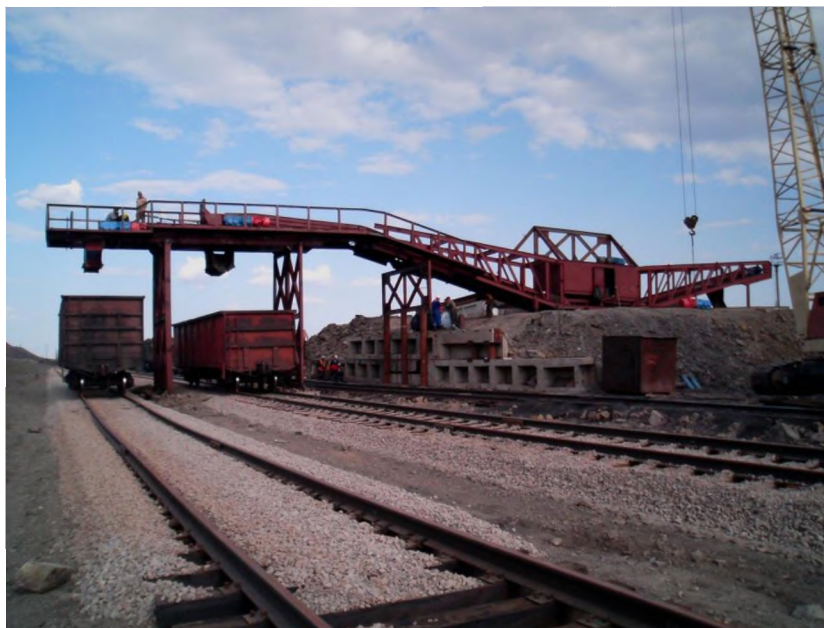
Рис.3. Конструкция комплекса ДСКА производительностью 1000 т/час в варианте поставки ОАО “Шубарколь Комир” (Республика Казахстан)
