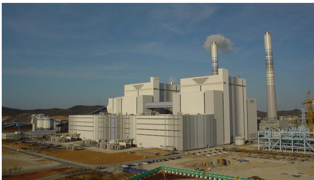
Рис. 4. Общий вид электростанции
