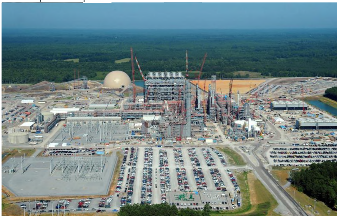
Рис. 2. Строительство ТЭС Kemper County, штат Миссисипи, США
