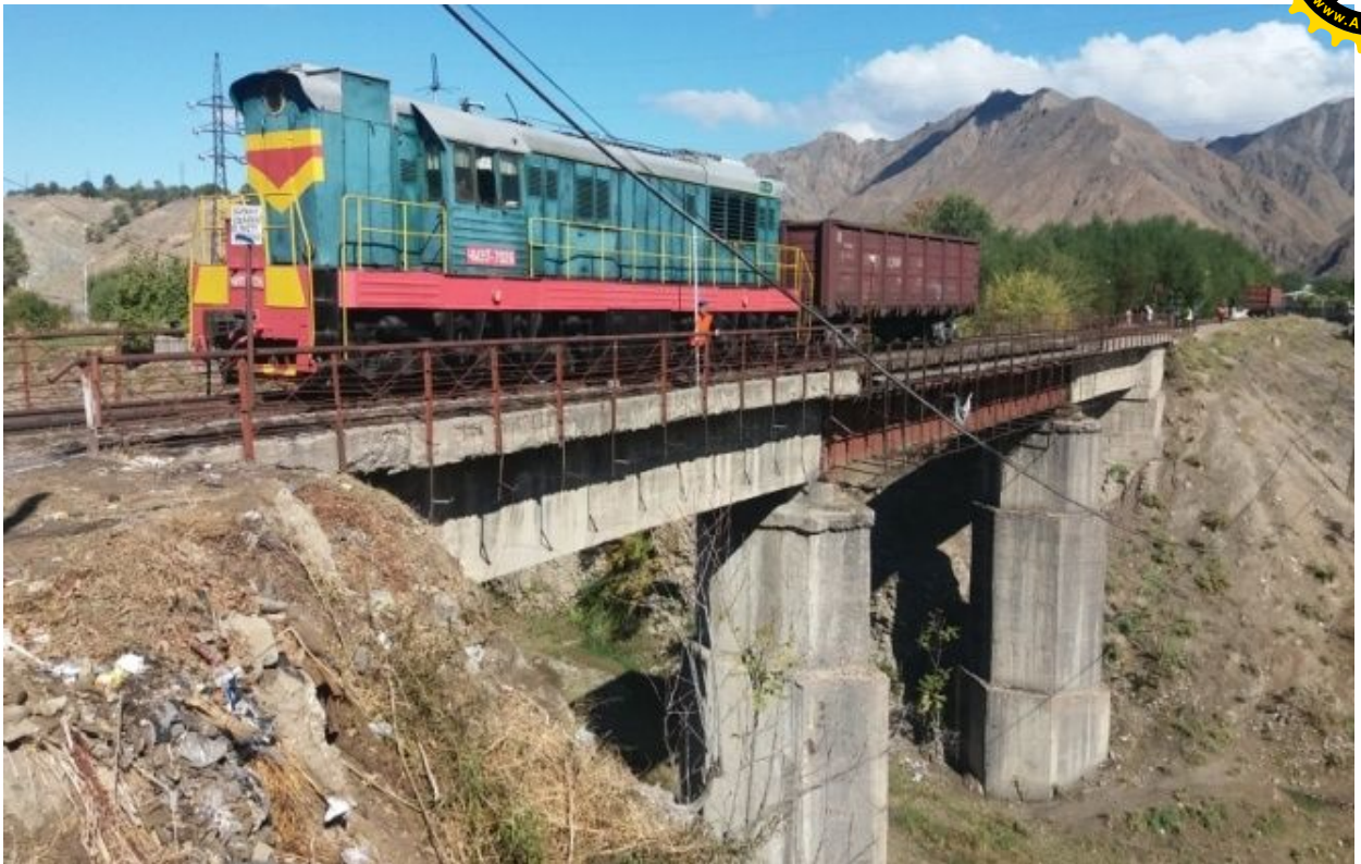
Рис.5. Загрузки моста подвижным составом
