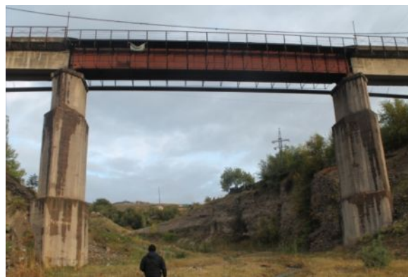
Рис. 2. Промежуточные опоры моста
