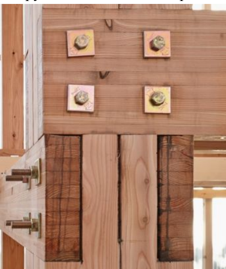
Рис. 6. Узловое соединение с использованием нагелей
