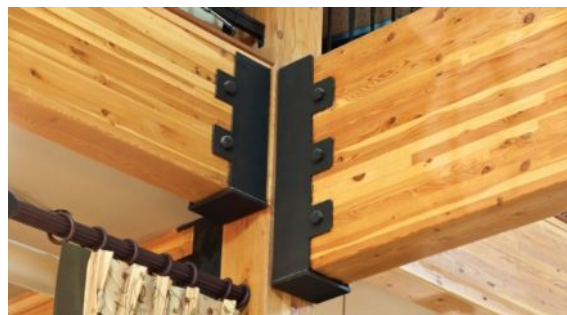
Рис. 5. Узловое соединение с использованием «металлического башмака»
