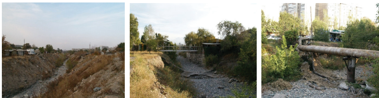
Рисунок 7– Состояние пойменных территорий р. Аламедин
