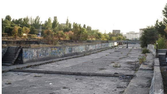
Рисунок 13 – Бетонное русло Южного Чуйского канала
