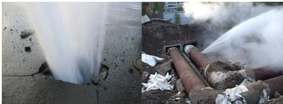
44 – сүрөт. Ысык суу менен камсыз кылуу тутумундагы бузулуулар.
