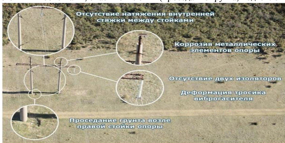
Рис.3. Обнаружение дефектов на ВЛ при помощи беспилотника.
