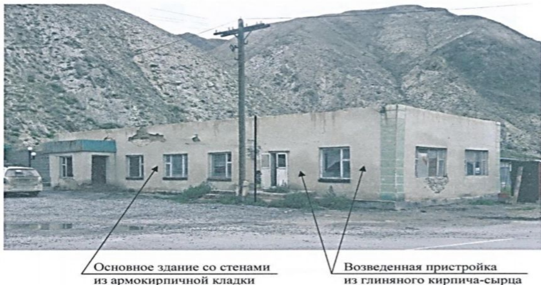
Рис.1. Общий вид обследованного здания
