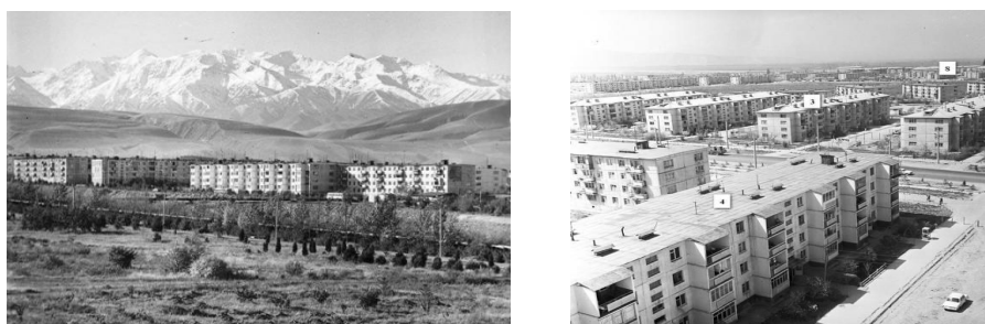
Рис.4. Строительство типовых домов в 80-е годы
