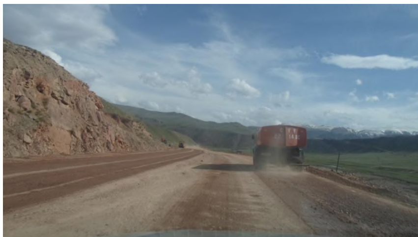
Рисунок 5. Реконструируемый участок дороги Перевал «Долон» (223-244 км)
