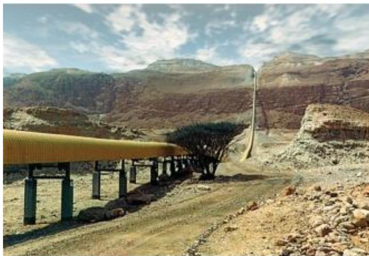
Рис 1. Канатно-ленточный конвейер, проложенный в условиях гористой местности.
