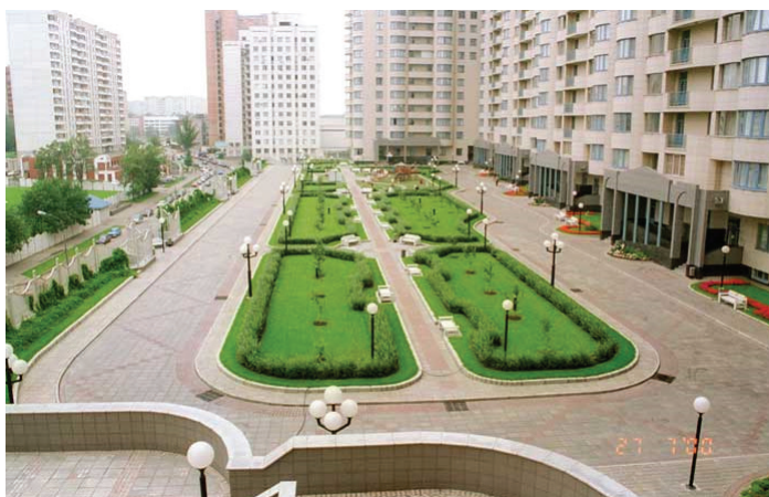
Рисунок 3 – Сад-бульвар на крыше подземного гаража в комплексе РАО “Газпром”, г. Москва
