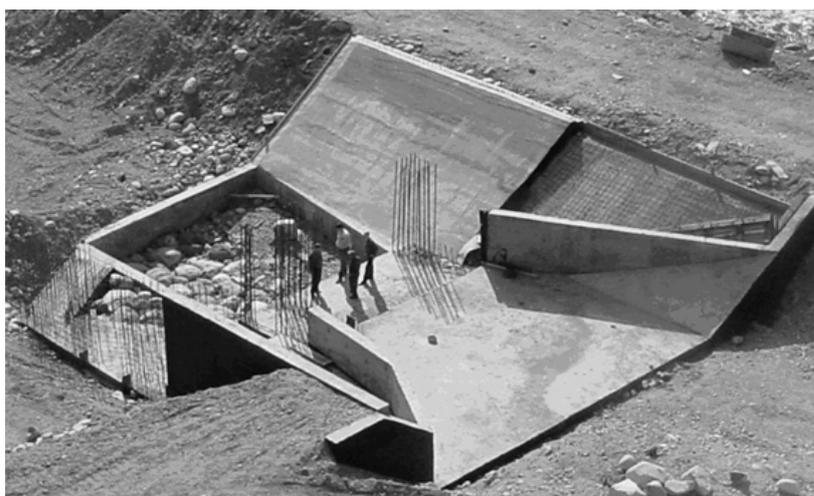
Рис. 2. Строящееся водозаборное сооружение для малой ГЭС Иссык-Ата.
